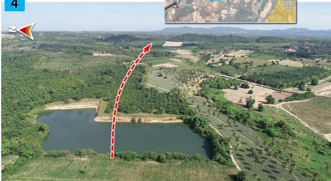
รูปที่ 6-2 สภาพพื้นที่โครงการตามแนวเส้นทาง (ต่อ)
