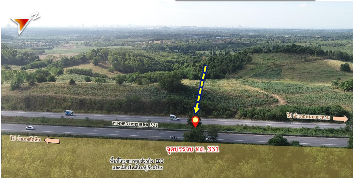
รูปที่ 6-2 สภาพพื้นที่โครงการตามแนวเส้นทาง (ต่อ)
